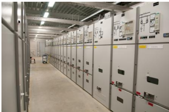
Grote MS-schakelinstallatie
