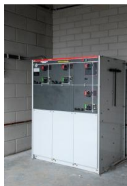
Kleine MS-schakelinstallatie
