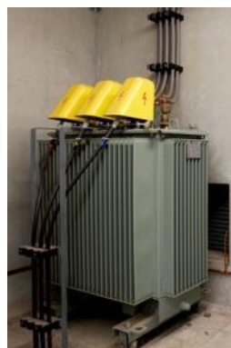
MS/LS-transformator
