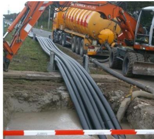
50 kV kabels
