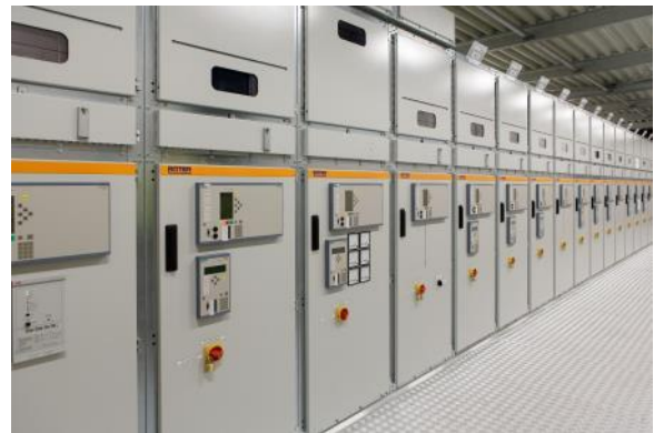
Grote MS-schakelininstallatie
