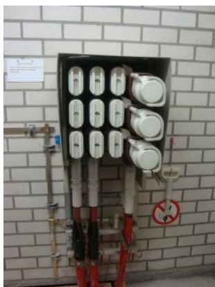
Kleine MS-schakelinstallatie
