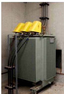
MS/LS-transformator
